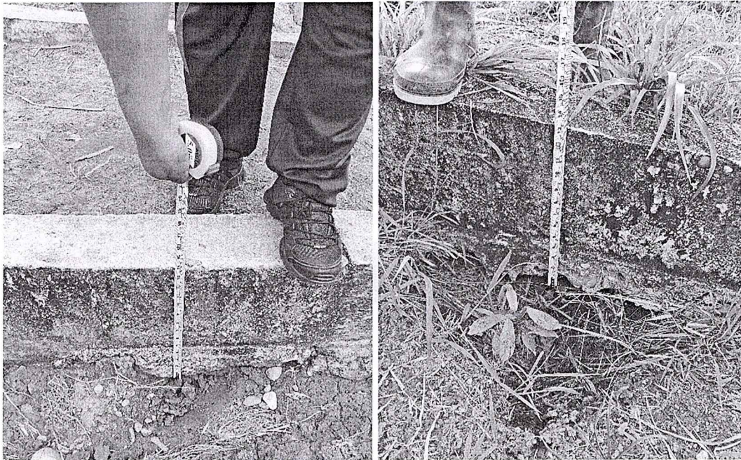
FOTOS 1: Altura típica fluctúa entre 30 cm y 45 cm (menor que 60 cm especificado).
