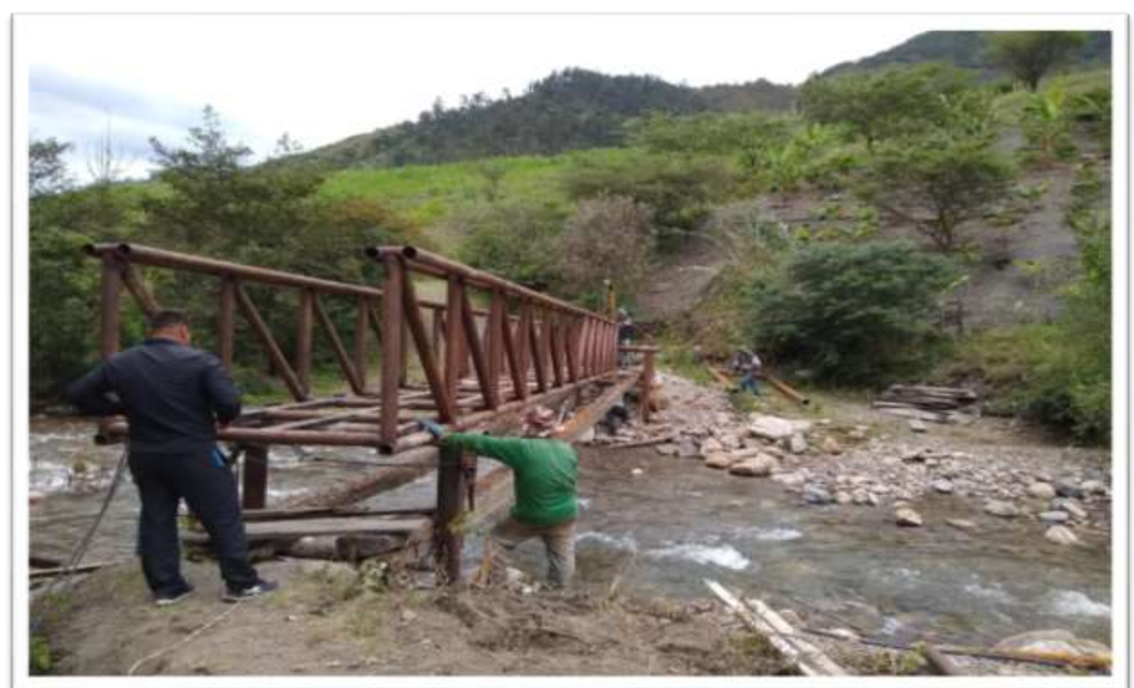
Ilustración 13. Construcción puente peatonal
