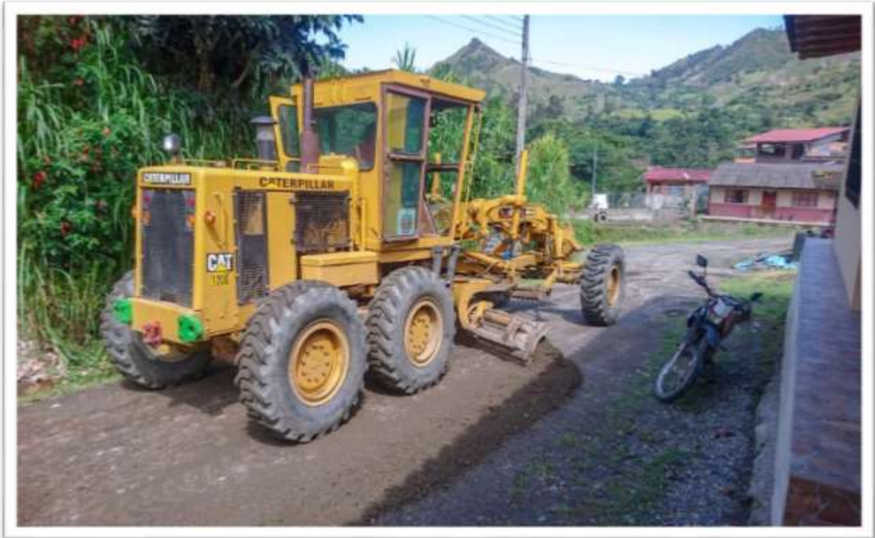
Ilustración 12. Mantenimiento vial en la parroquia
