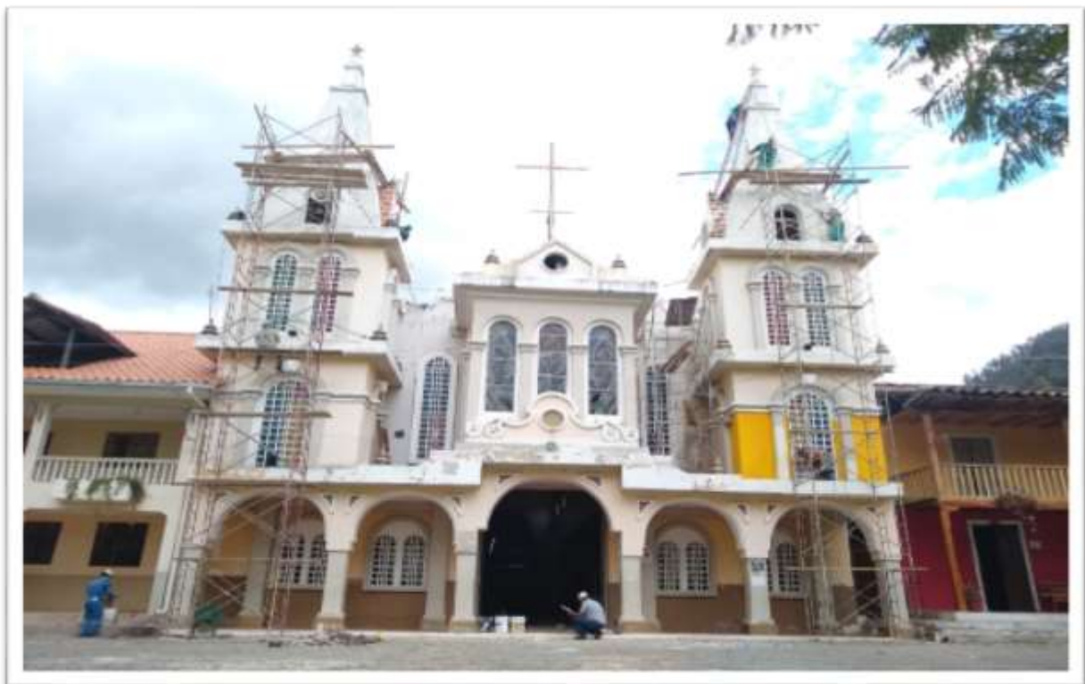
Ilustración 15. Intervención fachada de la iglesia central de Yangana
