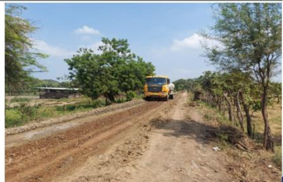
Trabajos en la vía sector: Creo en Dios
