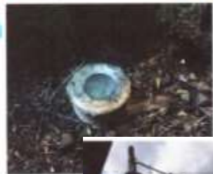
Sección de luminarias de piso, reflectores LED RGB y elemento de control del sistema de iluminación se encuentran quemados, se requiere la sustitución de los mismos y ejecutar el respectivo mantenimiento a las instalaciones eléctricas en general del monumento.
