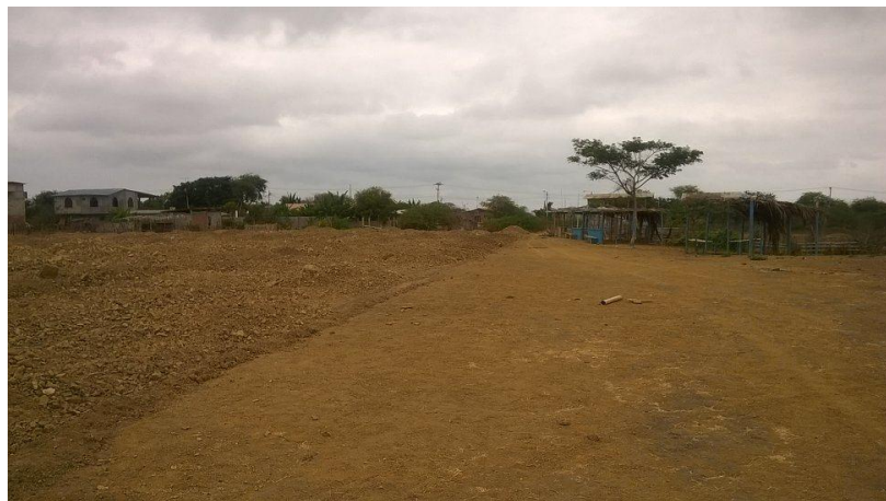
Ilustración 18 Cancha Recinto Data de Posorja en proceso de rehabilitación
