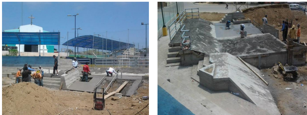
Ilustración 17 Obras construcción Canchas Multideportiva Barrio Las Cruces
