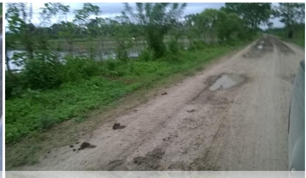
Foto 4. Vías de tercer orden; zona alta, vía Cerro
