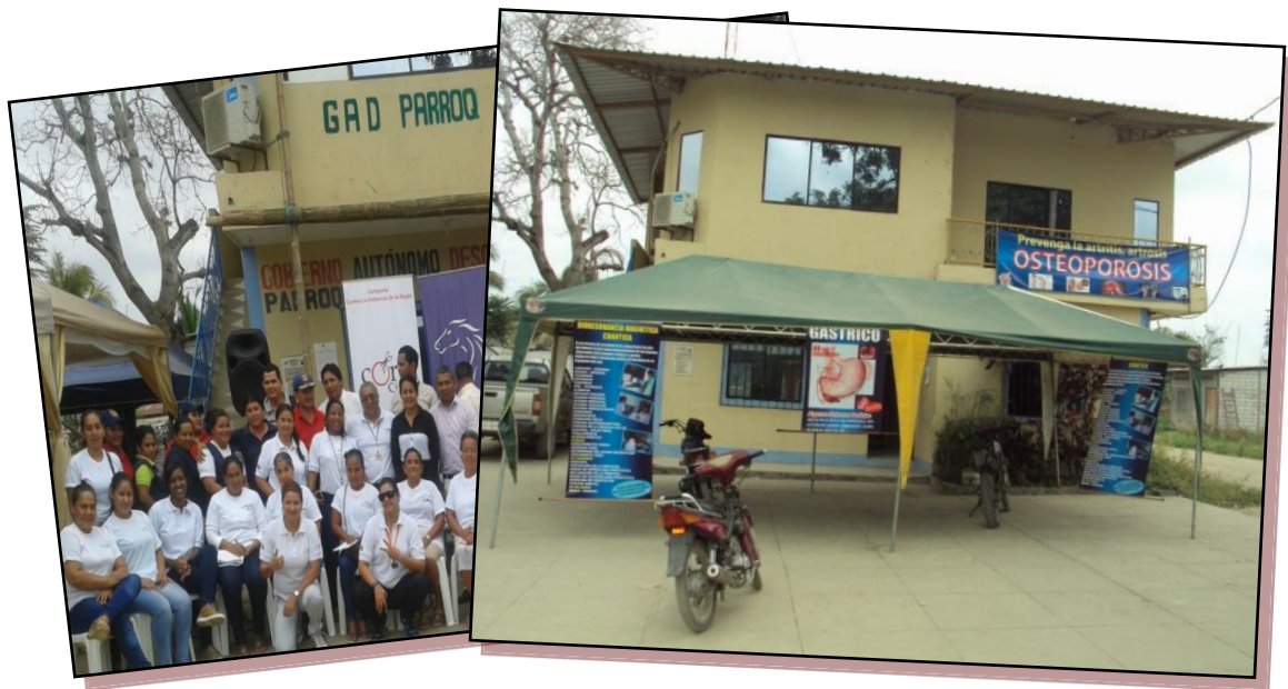
Foto 62, 63 .Edificio de dos pisos de GAD parroquial de San Jacinto.
