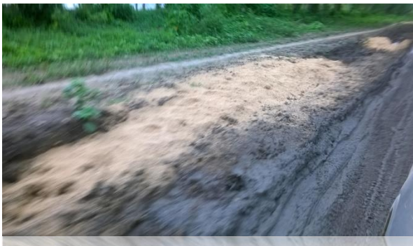
Foto 3. Vías de tercer orden; zona alta, vía Cerro
