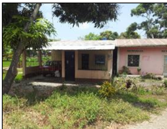
Foto 26. Casas en la cabecera parroquial que poseen pozo séptico y letrinas.
