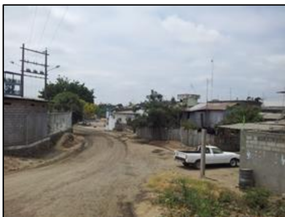
Foto 25. Calles lastradas, sin asfaltar. No se ha instalado sistema de alcantarillado.
