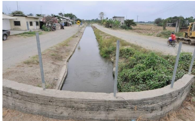
Gráfico 41: Infraestructura destinada al riego
