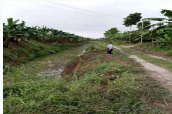
Limpieza de Canales
