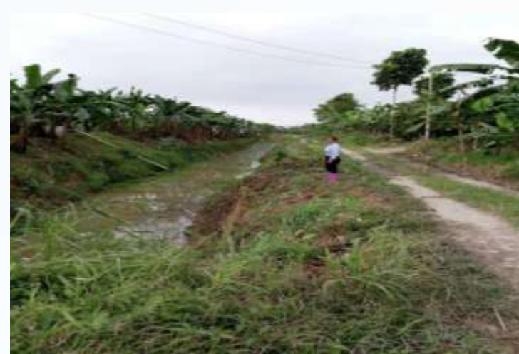
Limpieza de Canales
