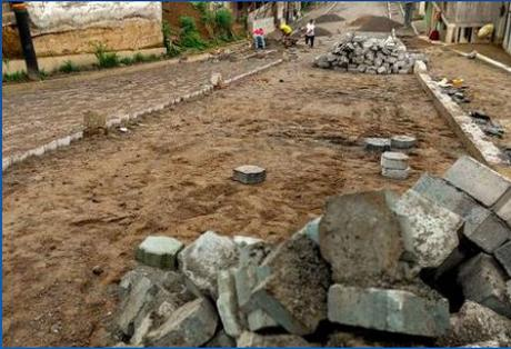
Adoquinado, bordillos y muro de gaviones en la calle Arturo Ruiz Mora entre Atahualpa y Rocafuerte
