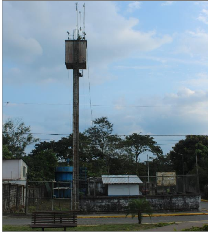
Planta de tratamiento de agua potable de la cabecera parroquial
