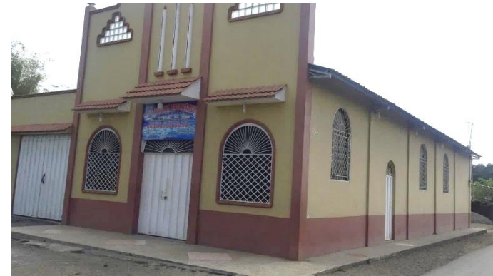
Fotografía 4-37: Iglesia situada en el Recinto Samborondón
