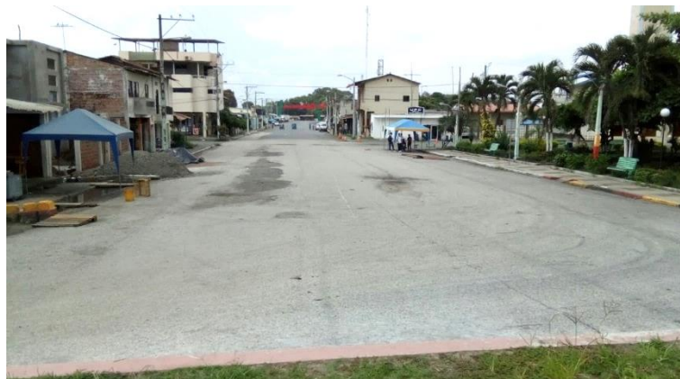
Fotografía 4-45: Vía de Tercer Orden
