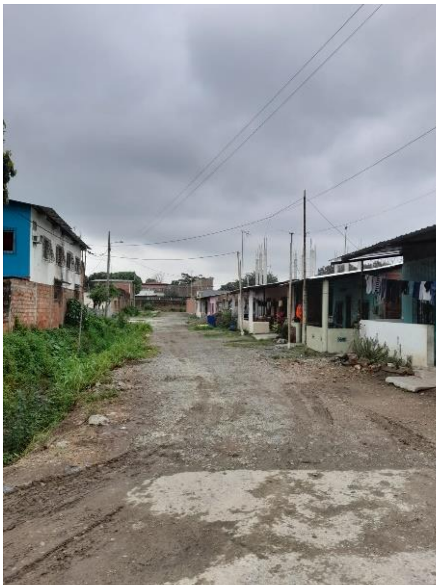
Gráfico 6: Falta de aceras y señalización
