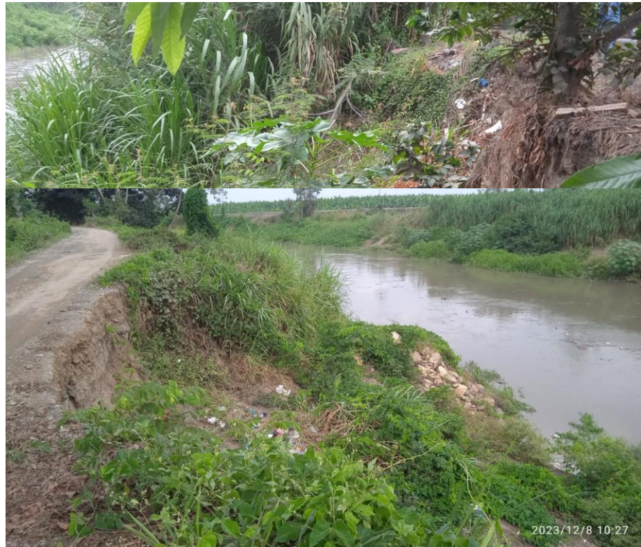
Gráfico 2: Deslizamiento de tierra en la parroquia
