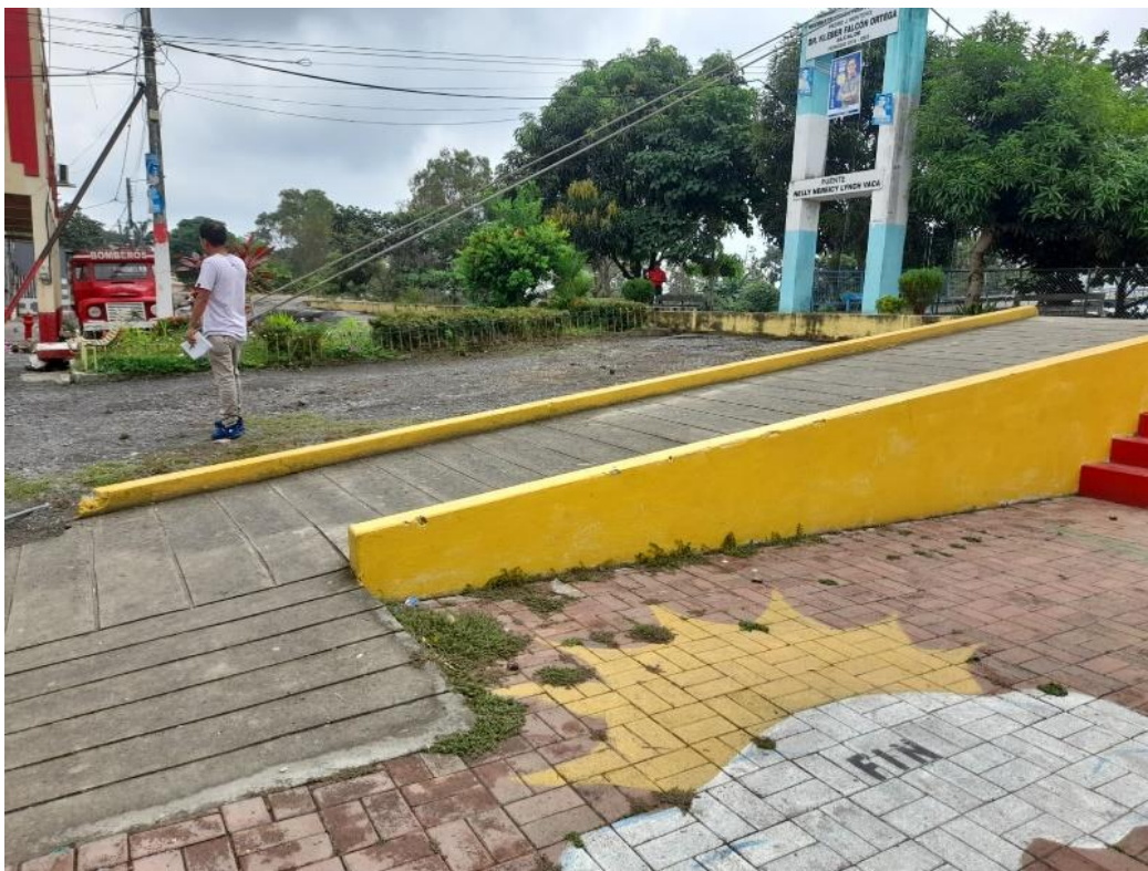
Gráfico 7: Rampa para acceso de discapacitados, elemento inclusivo en el Malecón de Gral. Pedro J. Montero (Boliche)
