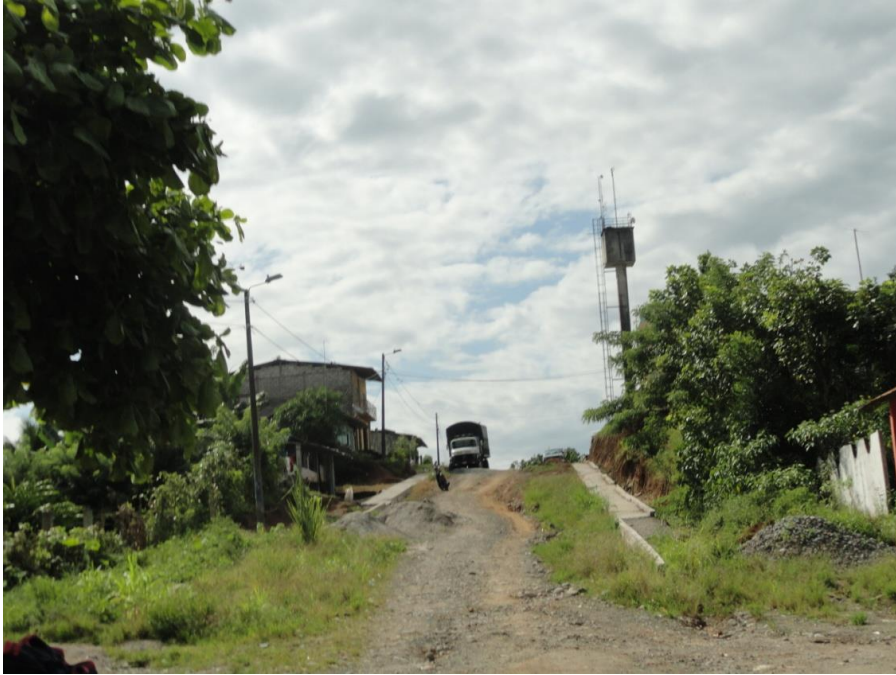
Ilustración 13. Vía local de tierra
