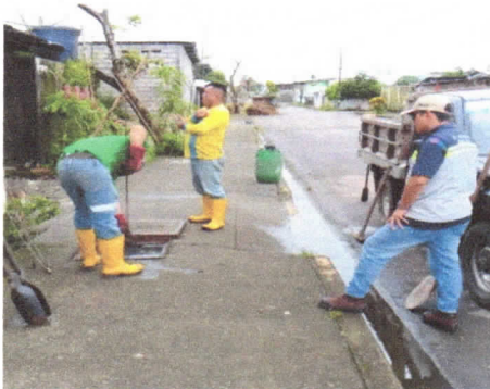
IMAGEN 23 TRABAJO DE LIMPIEZA DE CAJAS DOMICILIARIAS
