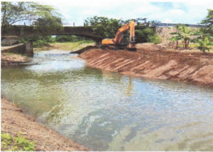
IMAGEN 20 MANTENIMIENTO Y LIMPIEZA DE ESTEROS RÍOS Y CANALES.
