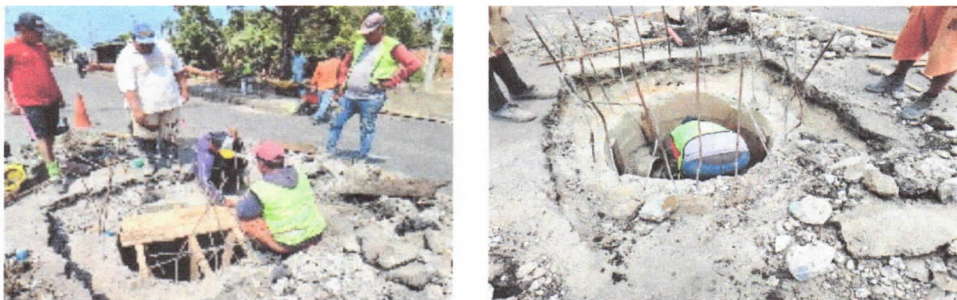
IMAGEN 29 RECONSTRUCCIÓN DE TAPAS DE ALCANTARILLADO.
