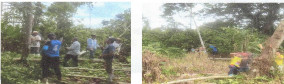
IMAGEN 33 MINGAS DE LIMPIEZA DE LÍNEAS ELÉCTRICAS
