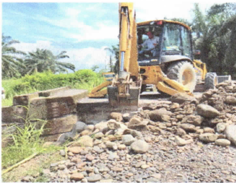
IMAGEN 18 REPARACIÓN DE PUENTE Y ALCANTARILLA
