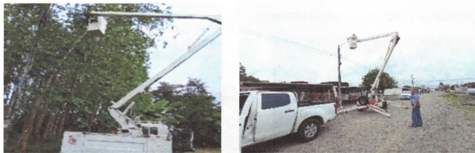
IMAGEN 36 MANTENIMIENTO DE LUMINARIAS
