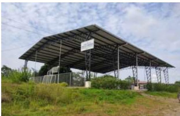
Fotografía 2- 43: Cancha cubierta / Comunidad Los Alpes Foto: Recorrido en campo PDOT 2020
