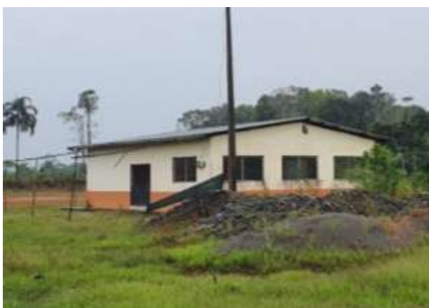
Fotografía 2- 49 Casa comunal/ Comunidad Valle Hermoso - Recorrido en campo PDOT 2020
