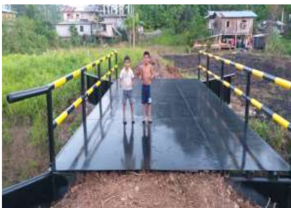
Fotografía 2- 61 : Puente de estructura metálica con tubería reciclada de petróleo/ Comunidad La Western Recorrido en campo 2020
