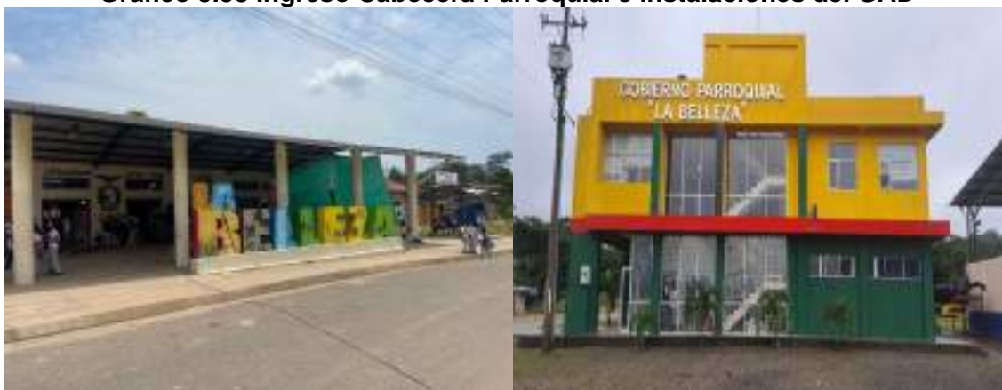
Gráfico 5.38 Ingreso Cabecera Parroquial e instalaciones del GAD
