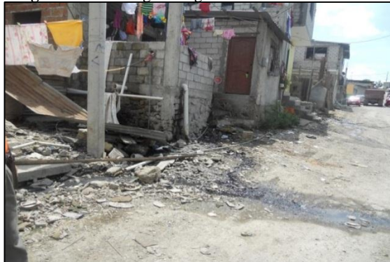
Fotografía 4.- Descarga de aguas residuales Recinto Cerecita.
