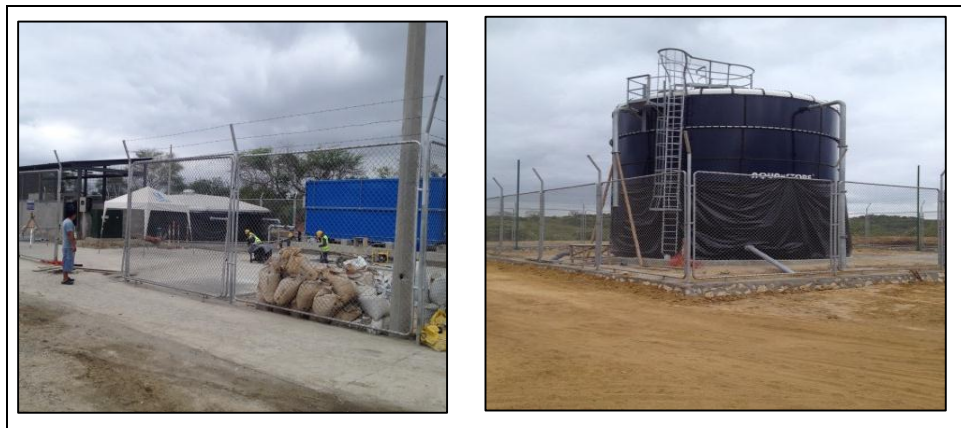
Fotografía 2.- Construcción de estación de bombeo de agua Potable y tanque elevado en el recinto San Lorenzo.
