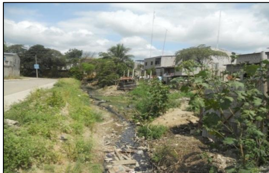
Fotografía 3.- Canal sin ducto cajón de aguas residuales en Barrio 10 de agosto
