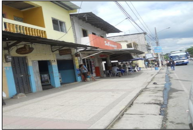
Fotografía 5.- Colapso de aguas residuales por falta de alcantarillado
