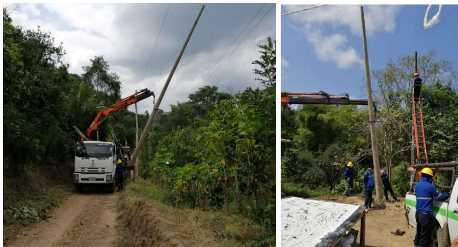
Imagen 24.- Poste par electrificación de las comunidades – Membrillo Fuente: Gad Parroquial Membrillo Elaborado por: Ing. Luis Villacreses Quimíz
