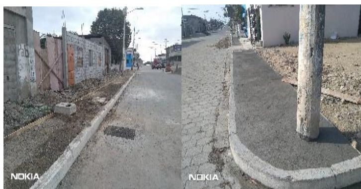
38.- Mantenimiento de las 6 aceras y bordillos- calle Bolivar Panchana.
