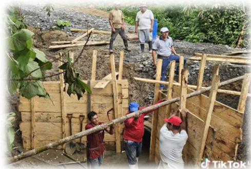
Donación de materiales para la construcción de alcantarilla en el sector de Chaupara Alto
