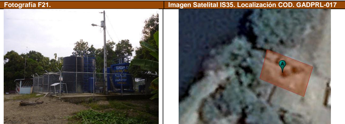
Sistema de Agua Potable-Parroquia Limonal.
