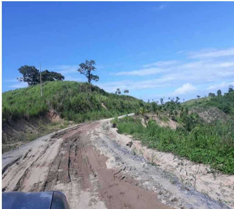
Vías en pésimo estado
