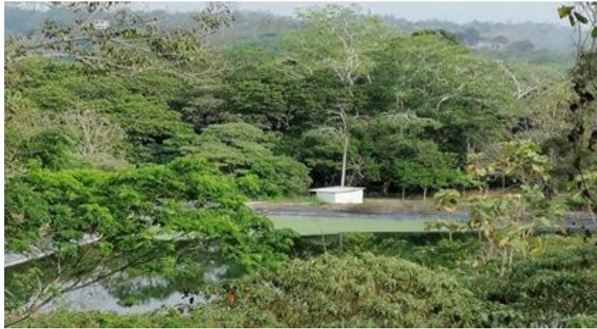
Piscinas de Oxidación. Sistema de Alcantarillado sanitario - Lagarto
