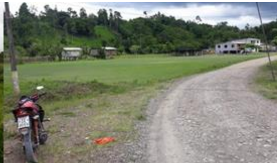
Vía a Bellavista en regular estado
