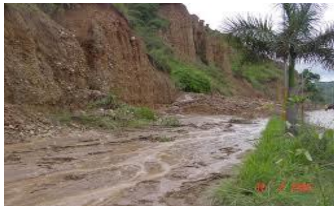
Deslizamiento via Anchayacu.
