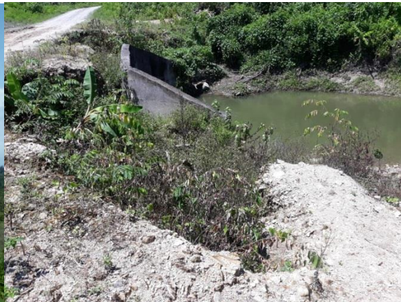
Alcantarilla Rio Culebrita
