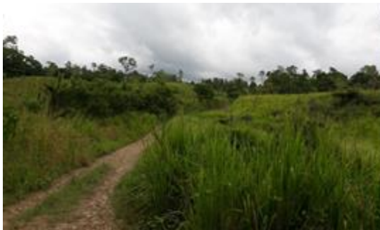
Vía a Cacho en Mal estado
