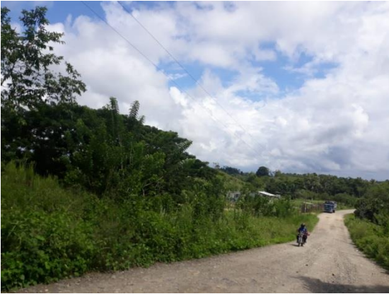
Vías en buen estado
