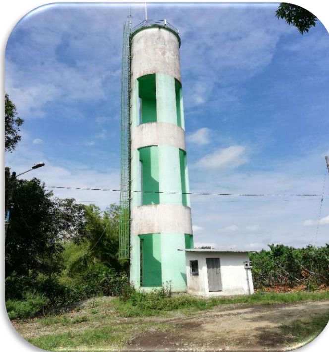
Ilustración 20: Tanque elevado para el abastecimiento de agua a la parroquia.
