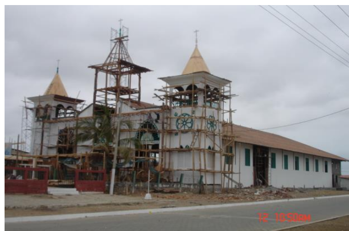
Trabajos de mantenimiento a la iglesia San Jacinto del Morro, icono de la parroquia.
