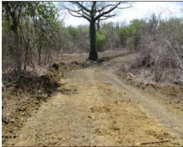
Fotografía 1.- Superficie de Erosión
