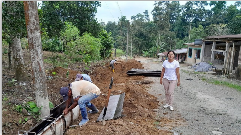
Inicio de obra.
