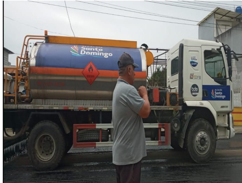
Inspección de la colocación de capa asfáltica en las calles aledañas al Parque Central
