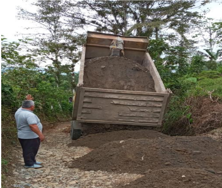
Acompañamiento a Volquetas de la Prefectura para riego de material en la vía antigua a la Comuna Polanco
