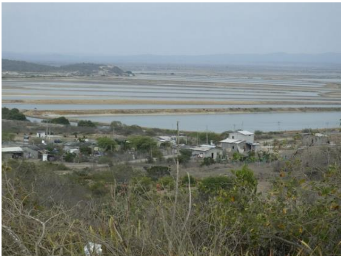
Gráfico 2 Pozos de Oxidación - Vista General
