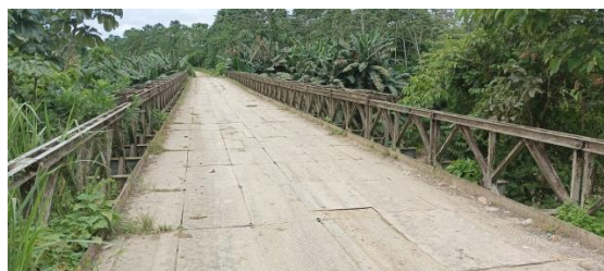
Puente sobre el río Rioverde
