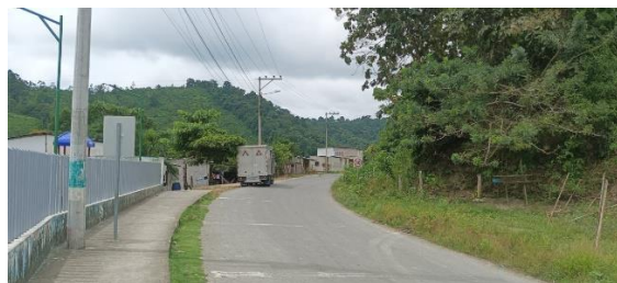
Vía de ingreso a la cabecera parroquial, recinto Zapallito
