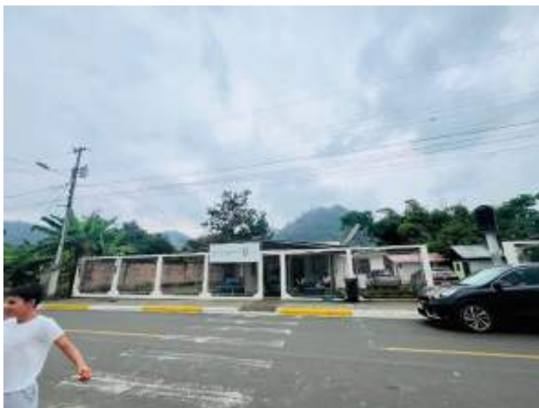
Ilustración 64. Centro de Salud Fuente: Equipo consultor, 2023
