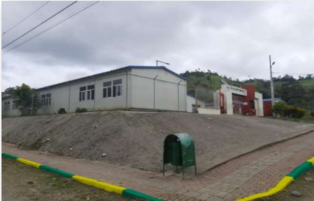
FOTOGRAFÍA 7. ESCUELA COMUNIDAD MONCAUNE (CERRADA)
