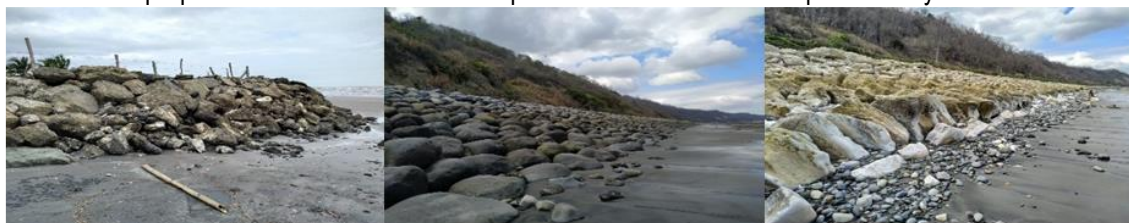
Figura 4. En la zona 1 hasta la zona 4 donde se observa escolleras adherentes y espigones perpendiculares al acantilado compuesto de material rocoso tipo basalto y lutita.
