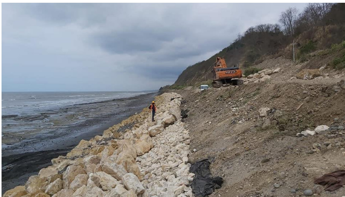
Foto. Riesgos Naturales – Escolleras para detener el oleaje
