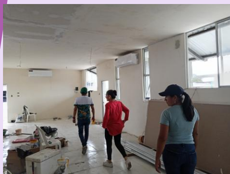
RECORRIDO EN OBRA DE REMODELACIÓN EN DIFERENTES ÁREAS, MANTENIMIENTO DE AIRES ACONDICIONADOS.
