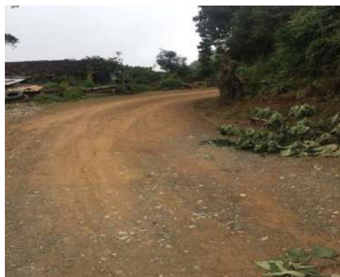
Foto 14. via de acceso al barrio El Batan
