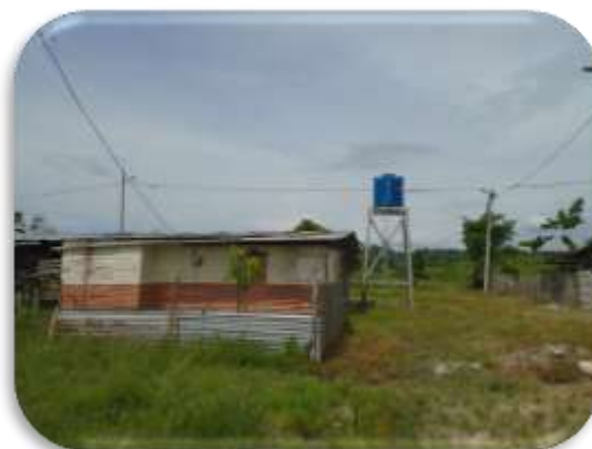
Tanques de reserva de agua
