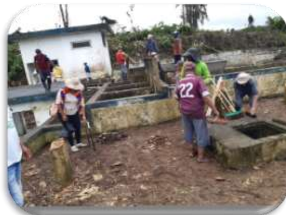
Planta de tratamiento agua
