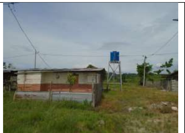
Tanques de reserva de agua
