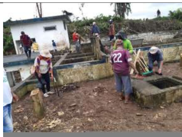
Planta de tratamiento agua
