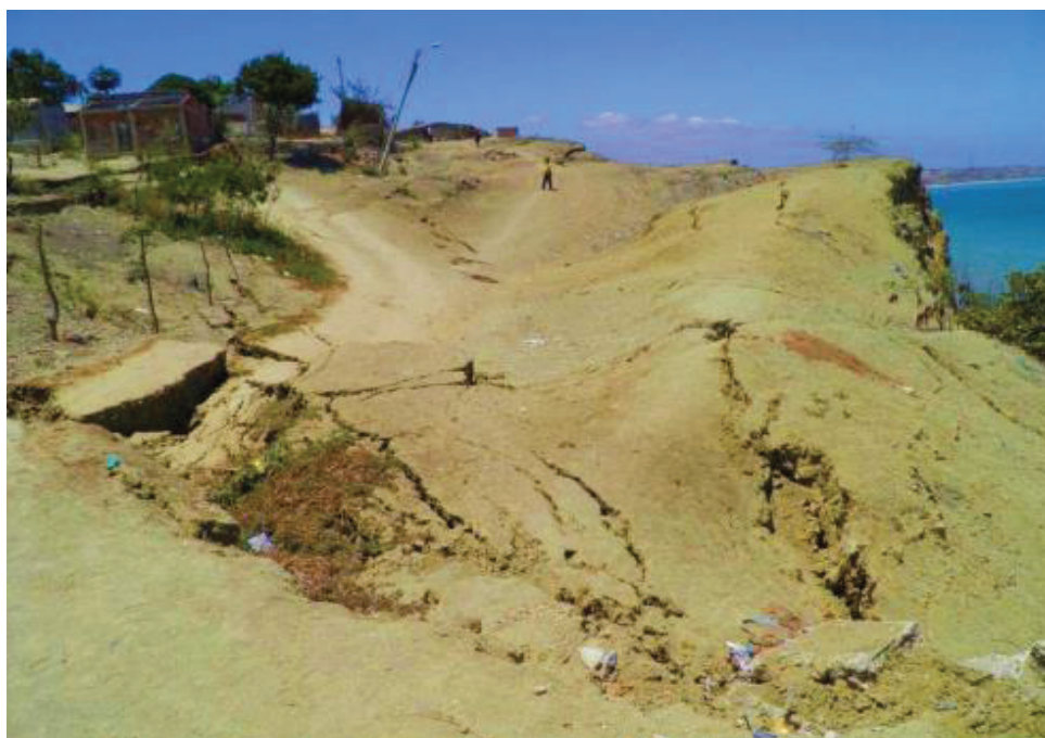
Gráfico 10. Deformación de terreno en el sector 2 de febrero en el año 2011, a causa del deslizamiento o movimiento de masa ocurrido
