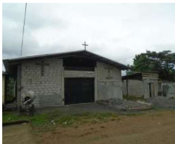
Iglesia en construcción
