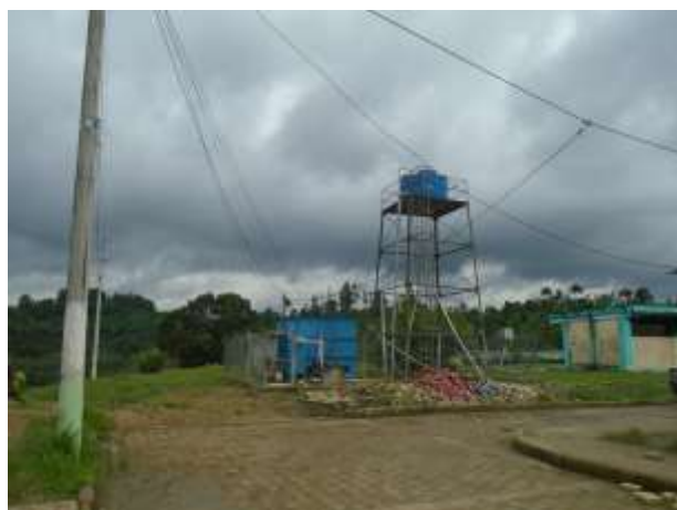
Sistema de agua potable
